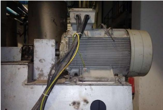
Am 21. November 2016 ging die Warn-E-Mail von B2 250 KW KALIP SOGUTMA FANI Gerät ein. Während der Inspektion durch das elektrische Wartungsteam wurde bestätigt, dass es ein Geräusch und Vibrationen im Lager des Motors gab. Seit dem 23. November 2016 besteht der Alarm weiter, da keine Wartungstätigkeiten an der Anlage durchgeführt wurden.
